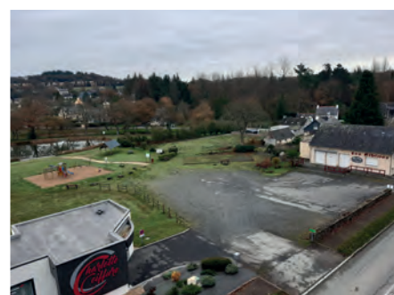
Ci-dessus : l'esquisse du projet de réfection et la vue actuelle de la place.
