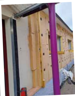
Isolation extérieure : deux couches de laine de bois d'une épaisseur de 100mm
